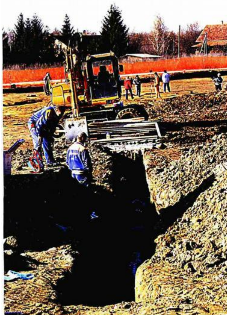
Arheolozi su na trasi pronašli srednjovjekovno selo. (u drugom planu) Zaštitni radovi usporavaju gradnju autoceste, ali graditelji gdje mogu postavljaju instalacije u zemlju
