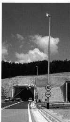
CESTOGRADNJA Dalekovod je sudjelovao u opremanju autocesta
